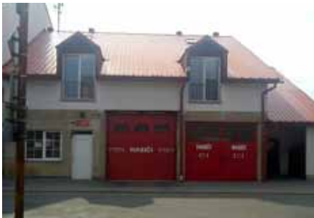
zbrojnice před úpravou
